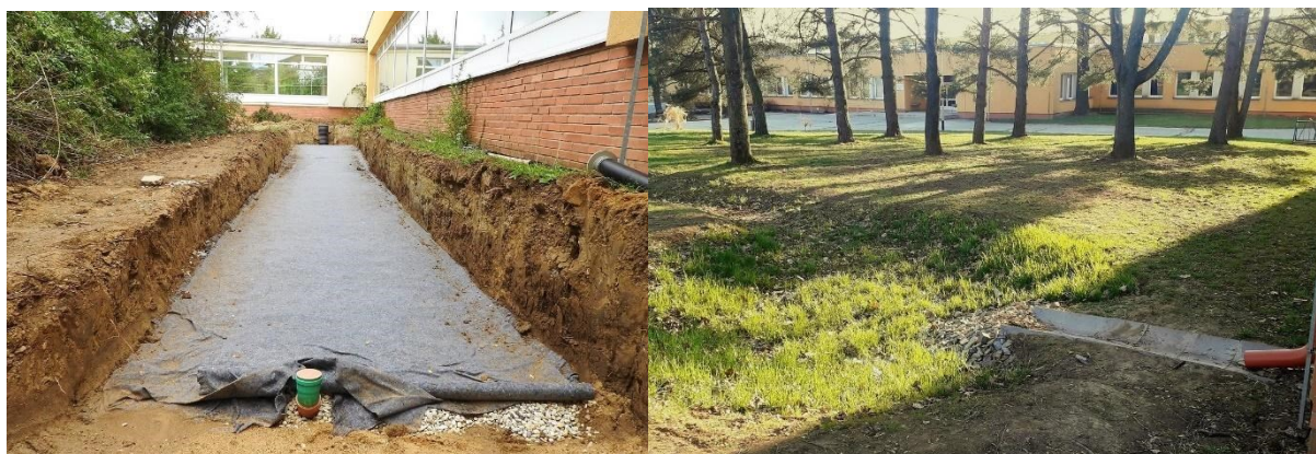
Obr. 51: Způsoby zadržování a zásaku dešťových srážek ze střech budov (ZŠ Uherský Brod)
