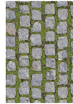
Parkovací místa s kvalitní žulovou dlažbou se širokou spárou pro vsak vody
