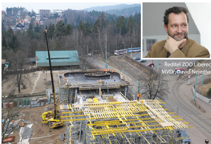
Rozestavěný nový vstup do zoo, tzv. budova A.
